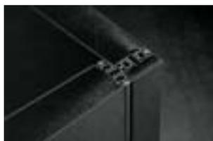
Détail de fixation à l'angle de deux cloisons monobloc.
