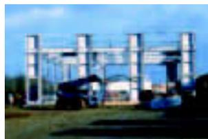
Hall de contrôle de véhicule à Savigny-le-Temple, France, dont la structure est composée de PRS et de profilé du commerce adapté au montage *in situ*. H. Fricout-Cassignol architecte.
