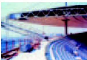
Poutres en treillis, structure de la couverture du stade de France. MZ/RC architectes.
