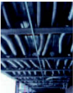
Passage des gaines techniques dans les poutres alvéolaires des planchers. Les poutrelles sont floquées pour assurer la stabilité à l'incendie.
