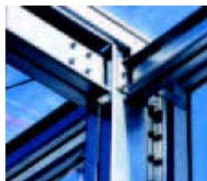
Structure en profils minces boulonnés. Viaduc espace info à Millau. M. Abergel et J. Carchon architectes.
