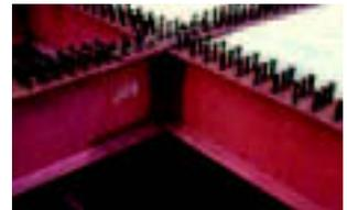
Ci-contre : plancher en dalles alvéolaires précontraintes posées sur une poutre asymétrique de type IFB (Integrated Floor Beam).
