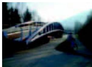
Passerelle fabriquée en atelier, en route pour être placée d'une seule pièce, garde-corps et platelage compris, au-dessus de la Leysse, France. Patriarche & Co architectes.
