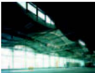
Poutres en treillis type Warren de la structure des ateliers de maintenance des tramways à Bordeaux. Jacques Ferrier architecte.
