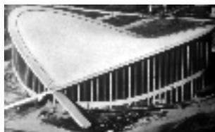
Exemple de structure à double courbure, paraboloïde hyperbolique. Arène de Raleigh Livestock réalisée en 1953 par Matthew Nowici avec l'ingénieur Fred N. Severud.
